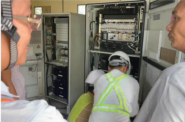
Baterías para estaciones base ZTE/Huawei: 48 V 150 Ah
