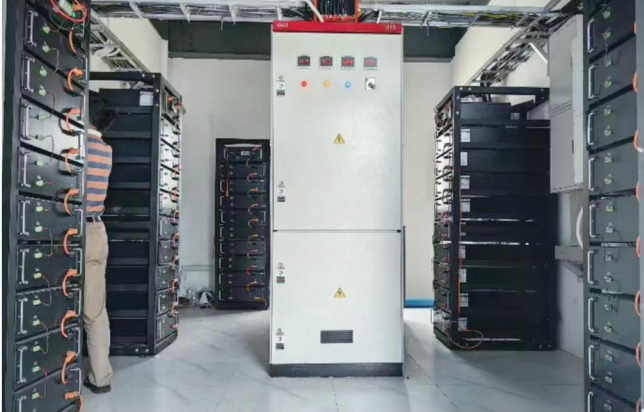
5 baterías de alta tensión en funcionamiento paralelo, fábrica textil de Rangún (Myanmar)
