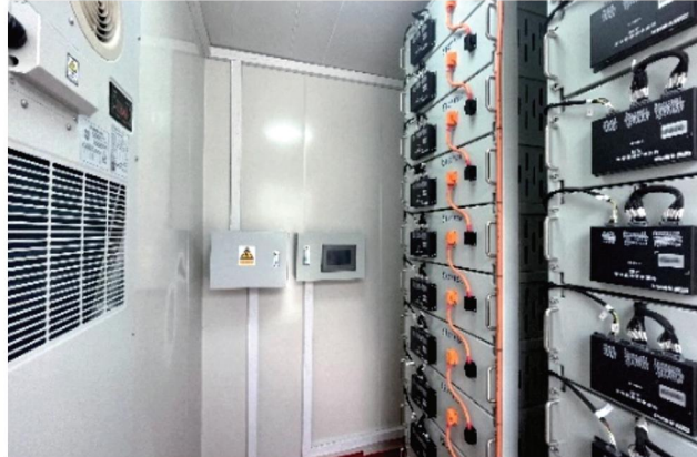
Regulación de frecuencia de central: 9 MW / 4,5 MWh
