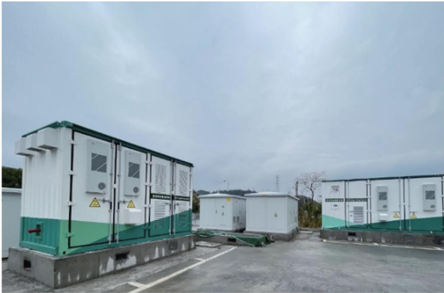
Estación de carga energética: 30 MW / 60 MWh
