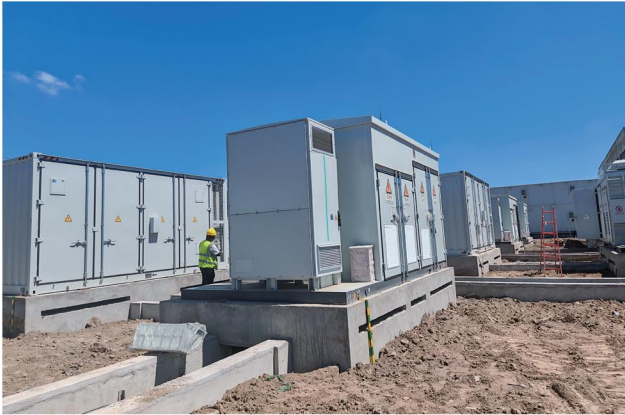
Contenedor de almacenamiento: Microrred inteligente 630 kW / 1 MWh
